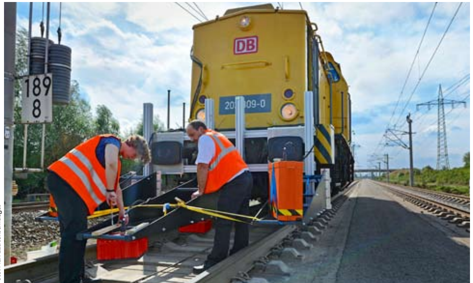
Um Hohlräume unter der Festen Fahrbahn auszuschließen, untersuchte DB Netz die Strecke mit Georadar.
