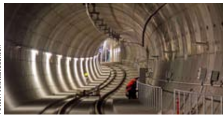
Zwei eingleisige Röhren unterqueren die City. Die Station „Markt“ ist einer von vier unterirdischen Haltepunkten.
