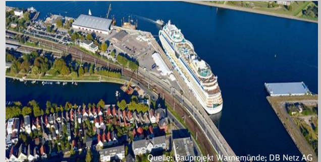
Quelle: Bauprojekt Warnemünde; DB Netz AG
