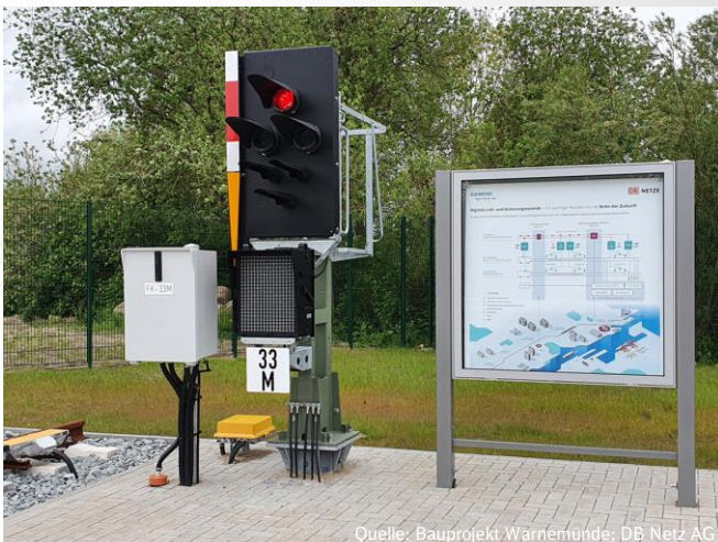
Quelle: Bauprojekt Warnemünde; DB Netz AG
