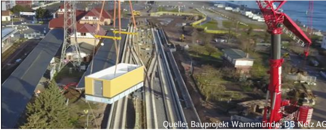
Quelle: Bauprojekt Warnemünde; DB Netz AG
